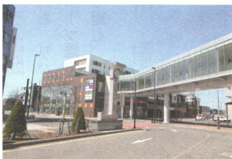
駅建物とビルが空中通路でつながっており外に出る必要がない。JR恵庭駅西口にビル共有駐車場完備
